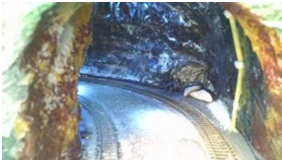
Figura 7.37 — Dentro do túnel.
